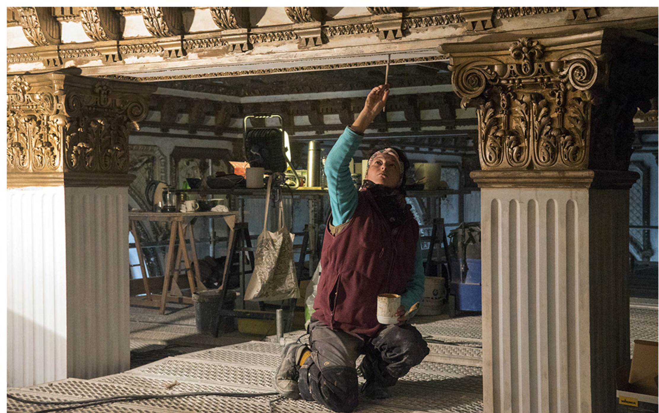
Restauration des gypseries et mise en couleur pour Marc Lavarenne - au salon doré - SAOU
